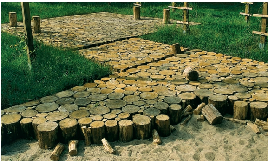
< Ścieżkę z drewnianych okrągłaków układa się na podsypce z piasku.
